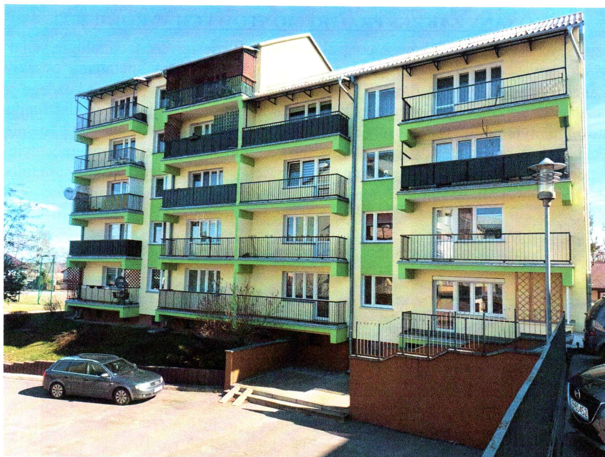
remont elewacji i balkonów przy ul. Łukaszyńskiej 46C,
