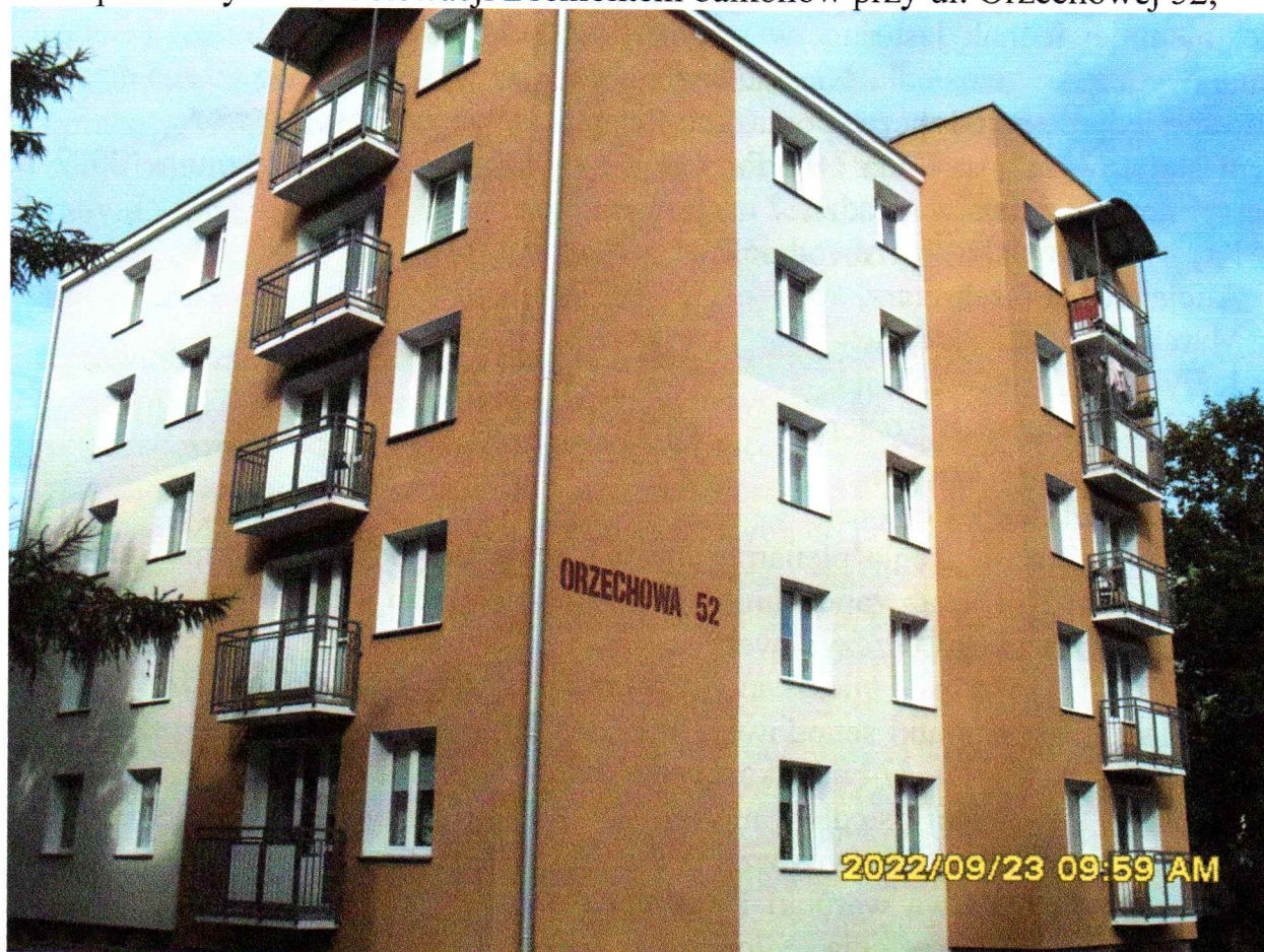
Kompleksowy remont elewacji z remontem balkonów przy ul. Orzechowej 52,
